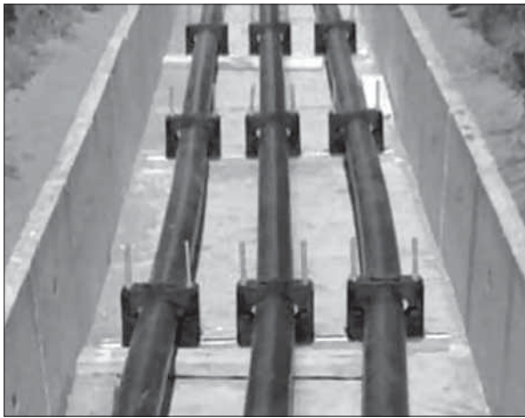
Рис. 2. Типова конструкція трифазної кабельної лінії електропередачі
