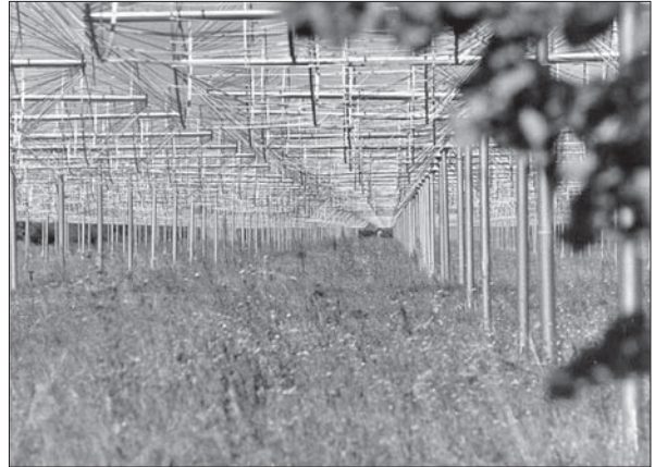
Рис. 1. Найбільший у світі радіотелескоп декаметрових хвиль УТР-2; f = 8\text{--}32 МГц, A = 150\,000 м 2 , N = 2040
