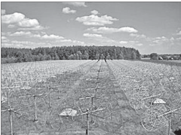
Рис. 2. Радіотелескоп системи УРАН; f = 8\text{--}32 МГц, N = 992 \times 2 = 1984
