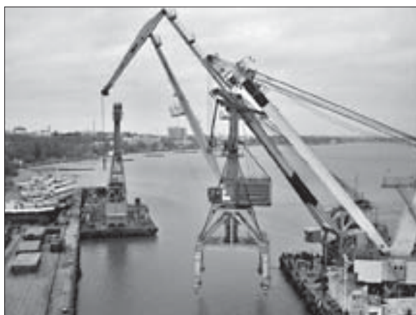
Водно-транспортні коридори України. Монтаж порталних кранів в порту Херсона
