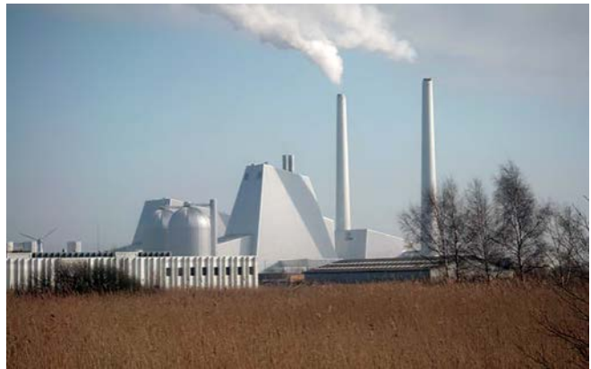
Рис.1. Загальний вигляд вугільної електростанції, переведеної на використання біомаси у м. Аведор, Данія [9, с. 8].
