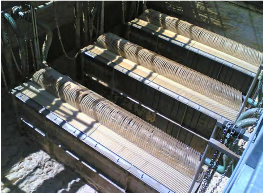
Рис. 3. Ультрафільтраційний мембранний модуль
