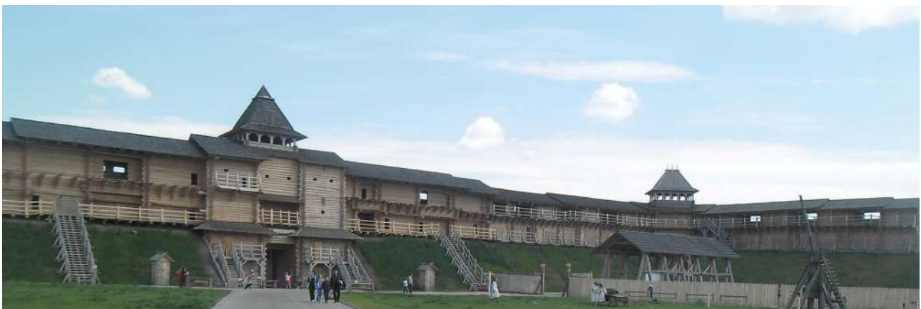
Ил. 20. Городни на насыпных неармированных валах. Вид со стороны города. Парк Киевская Русь. Фото 2014 года.
