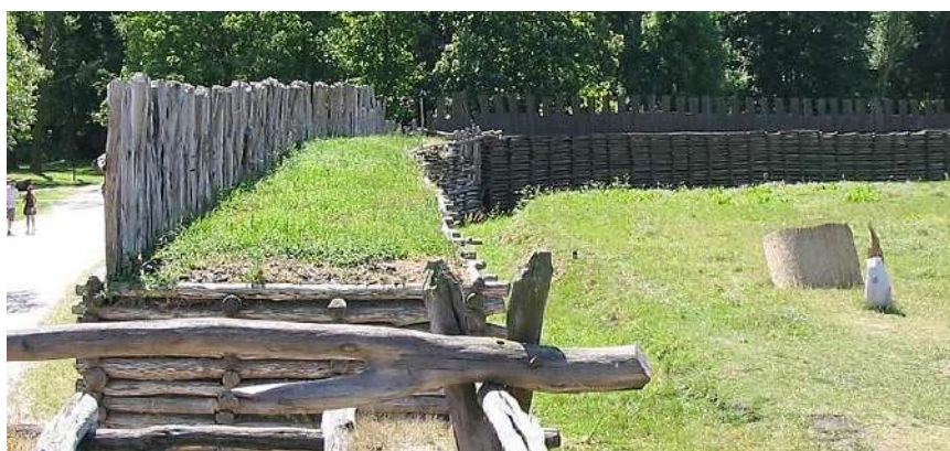
Ил. 18. Реконструкция простой деревоземляной стены из городен, которые забучены землей без обвалования. Вид с уровня боевой площадки в сторону городища. Польша. г. Бискубин.
