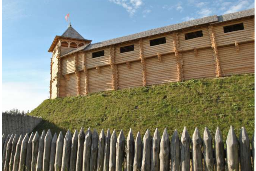
Ил. 21. Городни на насыпных неармированных валах. Вид со стороны поля. Парк Киевская Русь. Фото 2012 года.
