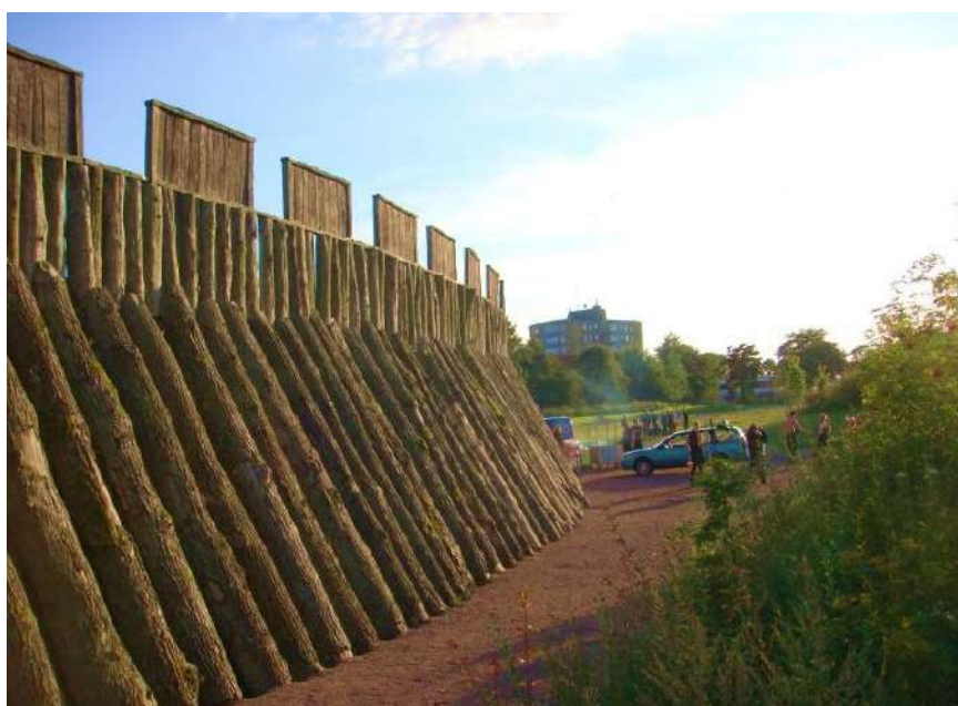
Ил.14. Реконструкция поселения викингов. Оборонная стена. Вид со стороны поля. Дубовые наклонные бревна, подпирающие вертикальные стойки парапета, выполняют функции контрфорсов, которые гасят давление грунта со стороны городища. Дания, г. Фуркат. Фото В. В. Янченко.
