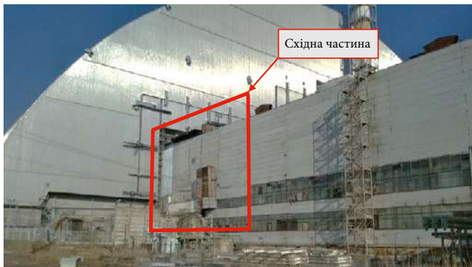
Рис. 3. Виступаюча частина об'єкта «Укриття» зі східної сторони НБК
