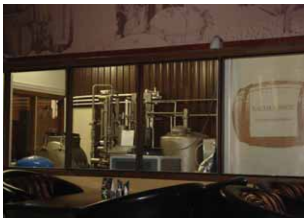
Рис. 10. Пивний зал з обладнанням
