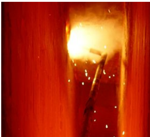
Рис. 1. Відновлення кладки камери коксування методом керамічної наплавки
