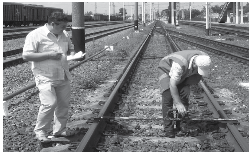
Рис. 7. Рейкові скріплення УС-1 у непарній колії 249 км ПК1 ділянки Основа – Букине Південної залізниці (між стрілочними переводами 550 і 572 станції Основа)
