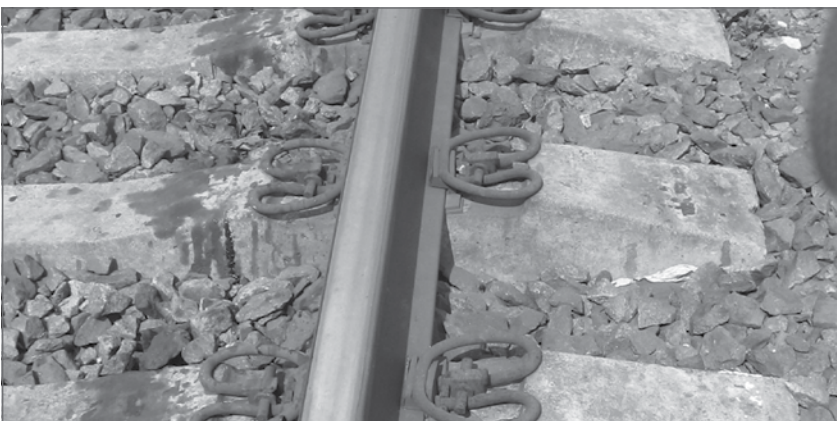
Рис. 5. Проміжне рейкове скріплення UC-1 (PRS-4 — аналогічне), розроблене в УкрДАЗТ
