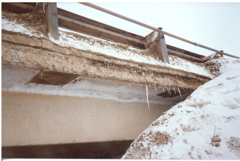
Рисунок 1 - Вид моста до ремонта
