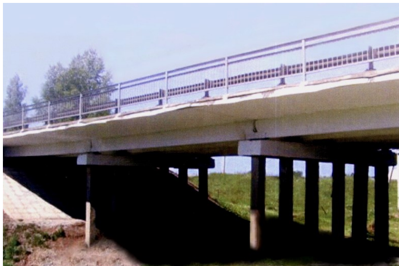
Рисунок 2 - Вид моста после ремонта
