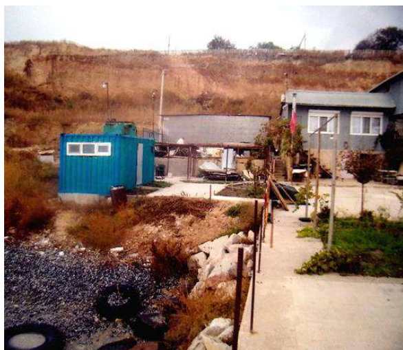
Рис. 1. Общий вид участка под устройство реабилитационного лечебно-оздоровительного центра
