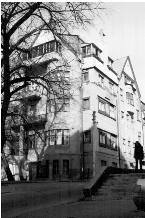
3. Ул. Маршала Бажанова, 14, архит. А.И. Ржепишевский
