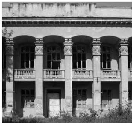
Рис. 2. Административное здание. Балтская дорога, 42
