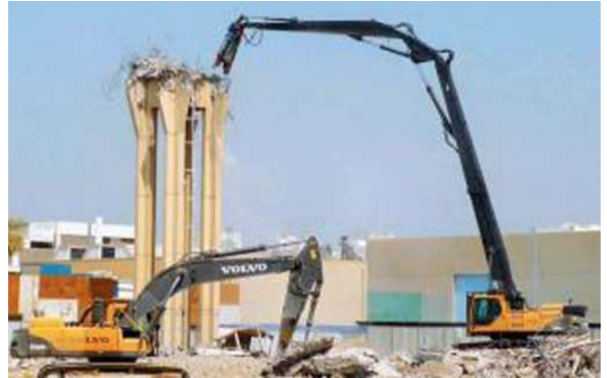
Рис. 6. Экскаватор с удлиненной стрелой с навесным оборудованием — гидромолотом (справа), экскаватор с обычной стрелой (слева)
