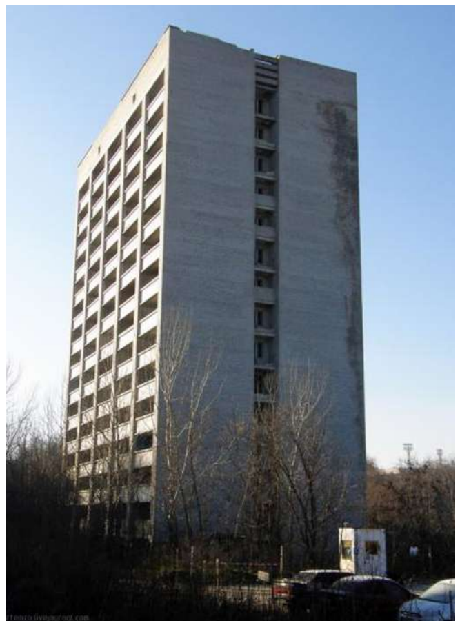
Рис. 1. Фото аварийного здания
