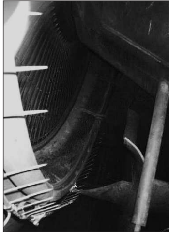
Рис. 2. Общий вид нейтрализатора на выходе турбины
