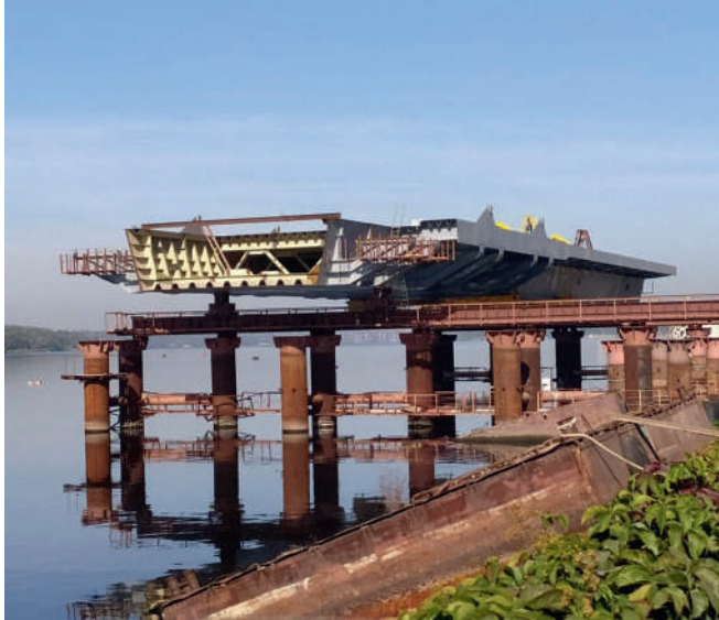
Рисунок 2 — Вигляд на укрупнену частину прогонової будови, що чекає на відправлення для монтажу в проектне положення
