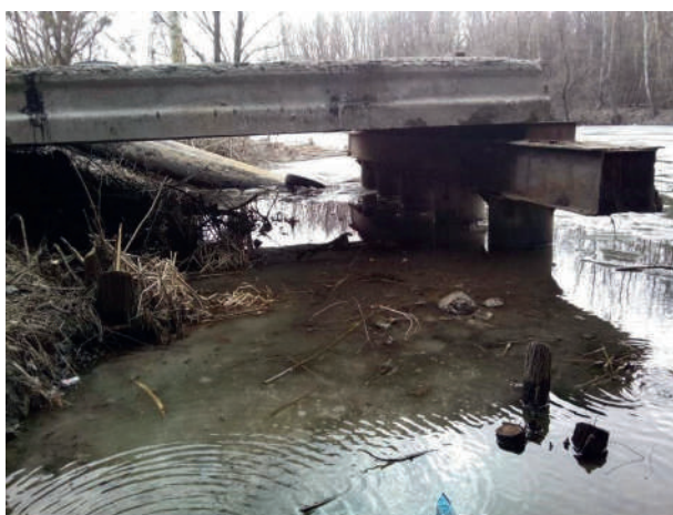
Рисунок 21 — Фасад змонтованого прогону довжиною 9 м. На довжині 3 м від берегової опори балки лежать на лежні із залізобетонних плит
