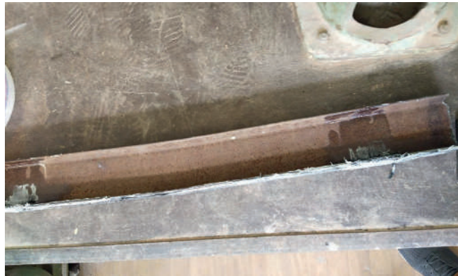
Рисунок 12 — Підсилена двотаврова балка після випробування
