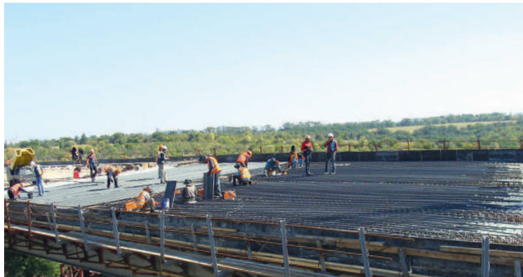
Рисунок 7 — Армування залізобетонної плити сталезалізобетонної прогонової будови
