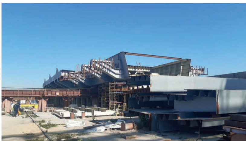
Рисунок 1 — Стапель для укрупнення елементів прогонових будов
