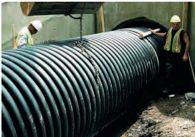
Рисунок 6 — Санація (гільзування) залізобетонної труби в м. Вілмінгтоні, штат Делавер
