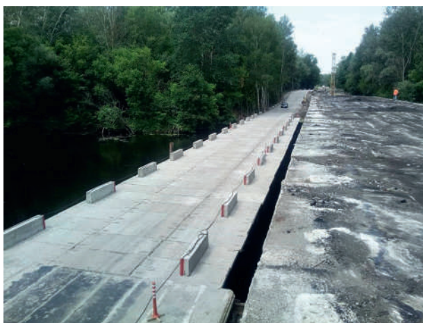
Рисунок 23 — Загальний вигляд побудованого тимчасового моста
