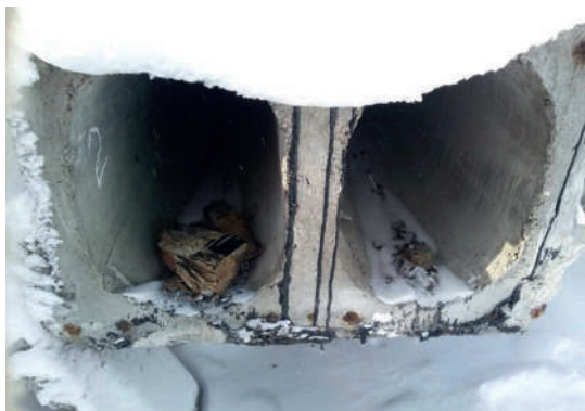
Рисунок 8 — Торець балки № 2, видно розташування арматури
