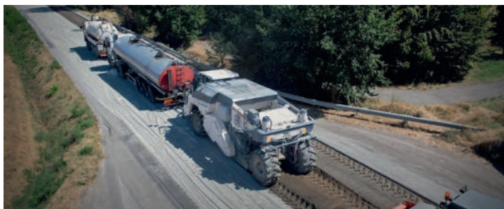
Рисунок 5 — Виконання робіт за технологією холодного ресайклінгу на дорозі [21]
