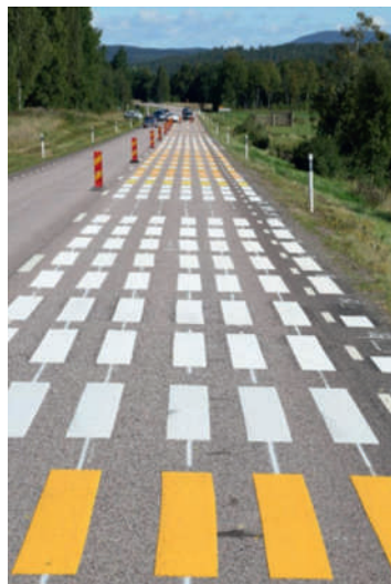
Рисунок 4 — Дослідна ділянка для проведення дорожніх випробувань
