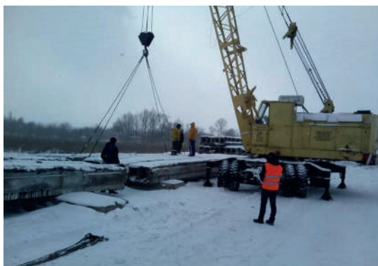
Рисунок 9 — Перекладання балок за допомогою гусеничного крана, проведення вибравочки
