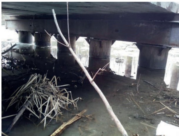
Рисунок 22 — Опора і ригель тимчасового моста
