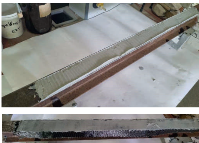
Рисунок 4 — Процес нанесення клею MareWrap 11 та приклеювання вуглецевих стрічок Marei MareWrap C UNI-AX 600/10
