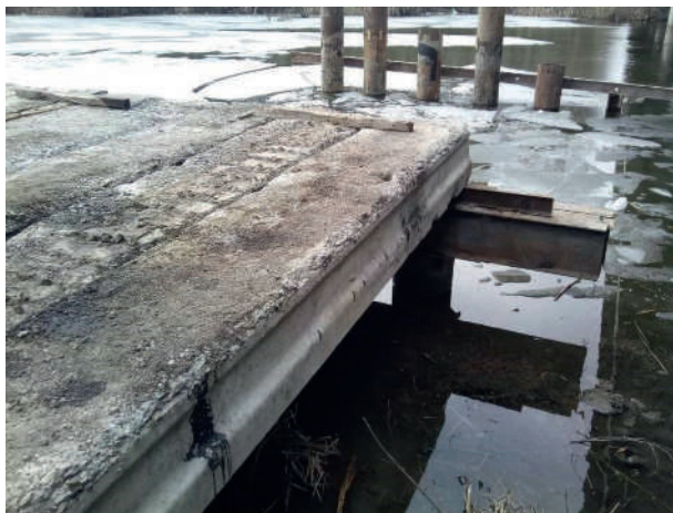
Рисунок 19 — Прогонова будова і опора тимчасового моста
