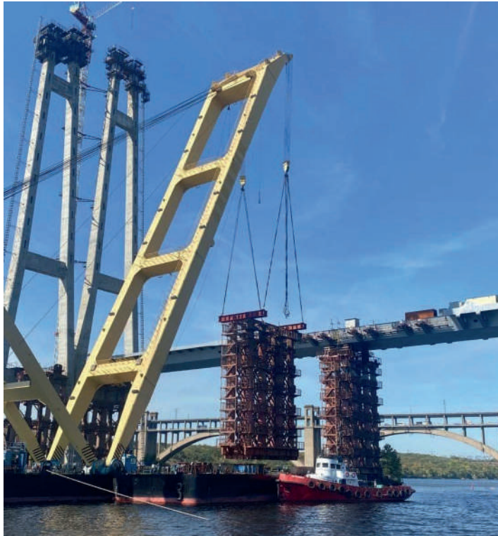
Рисунок 4 — Монтаж тимчасової опори в проєктне положення руслової частини р. Дніпро
