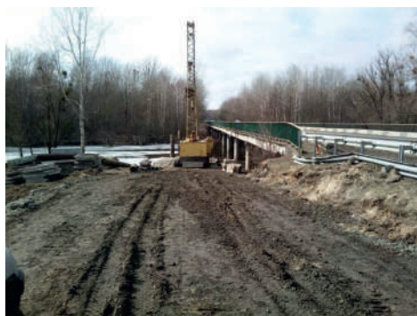
Рисунок 18 — Загальний вигляд будмайданчика при спорудженні тимчасового моста
