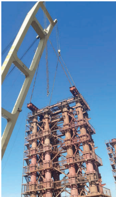
Рисунок 3 — Кран «Захарій». Стрповка тимчасової опори
