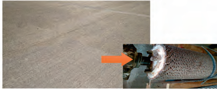
Рисунок 7 — Відновлення шорсткості бетонного покриття за допомогою алмазного інструменту
