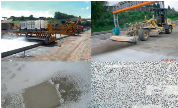
Рисунок 6 — Створення шорсткої поверхні покриття за допомогою технології «Waschbeton»
