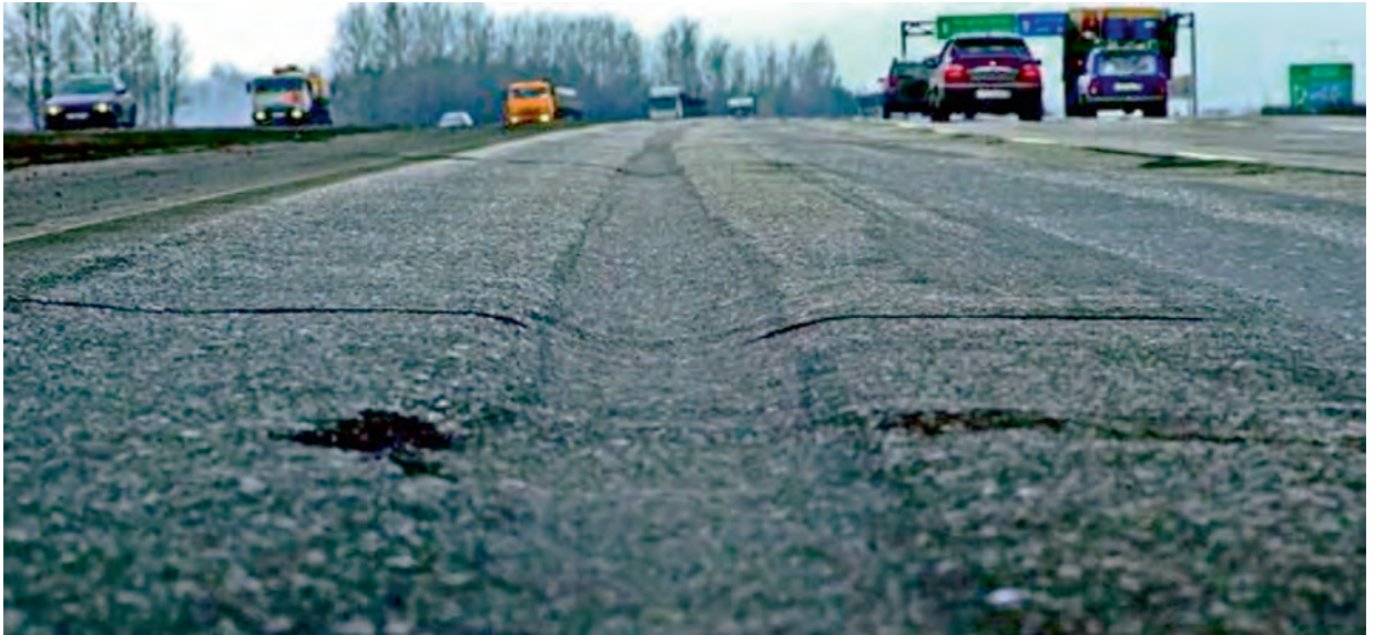
Рисунок 1 — Ділянка автомобільної дороги з характерними деформаціями, як наслідок сегрегації
