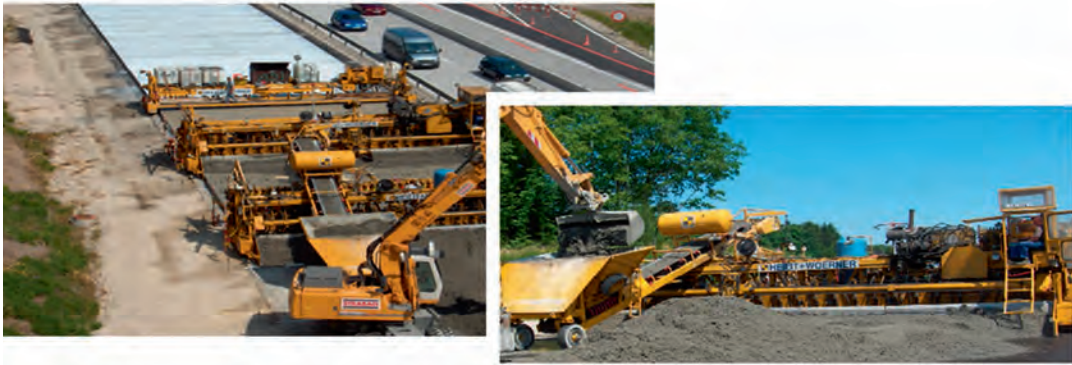
Рисунок 3 — Одночасне влаштування двох шарів цементобетонного покриття
