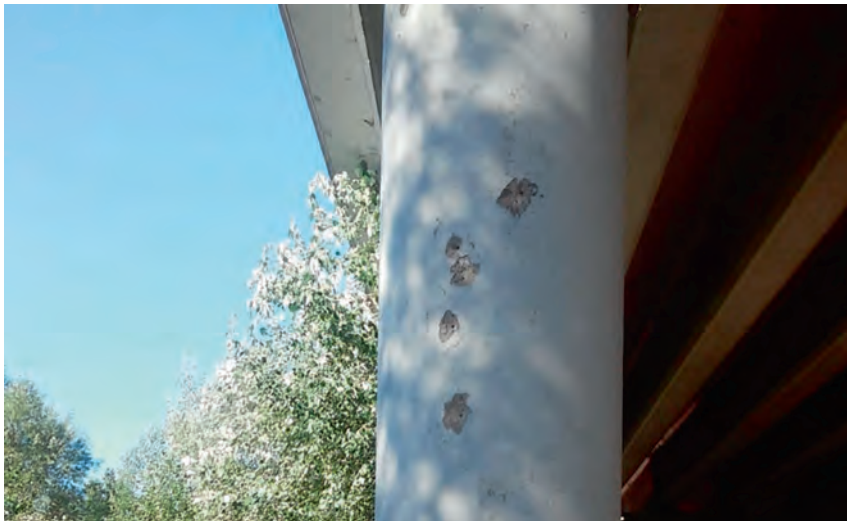
Рисунок 5 — Сколи бетону від кульових влучень без оголення арматури до 2 % від площі
