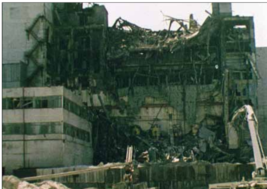
4-й енергоблок ЧАЕС після аварії.
