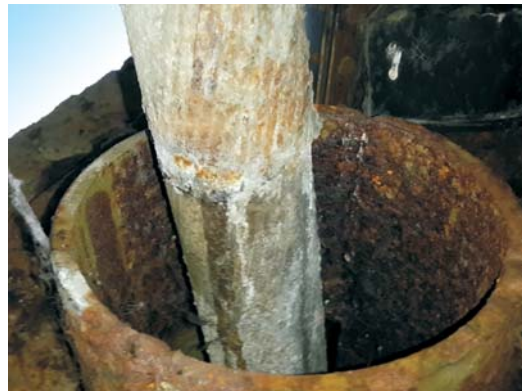
Рис. 6. Стан заанкерених канатів вантів для відтягування пілона
