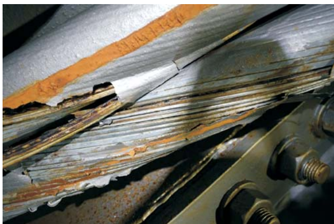
Рис. 7. Руйнування і обриви дротин канатів вантів
