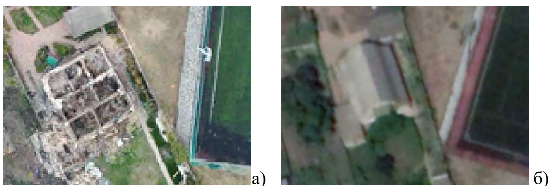
Рис.6. а) повністю зруйнований будинок; б) будинок до руйнації
