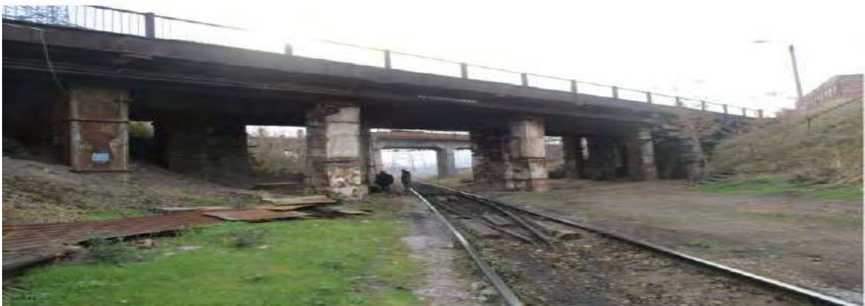
Рис. 2. Загальний вигляд шляхопроводу
