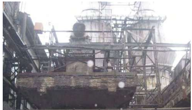
Рис. 2, б. Споруди між корпусами електролізного цеху
