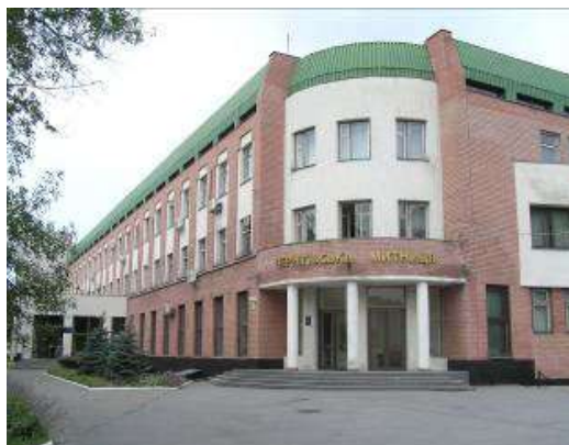
Адміністративна будівля Чернігівської митниці
