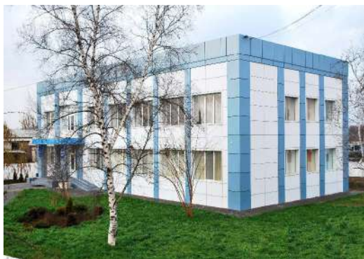
Митний пост «Херсон – центральний». Загальний вигляд будівлі, у якій розташований підрозділ митного оформлення
