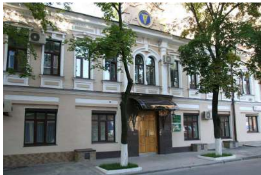
Адміністративна будівля Харківської митниці
