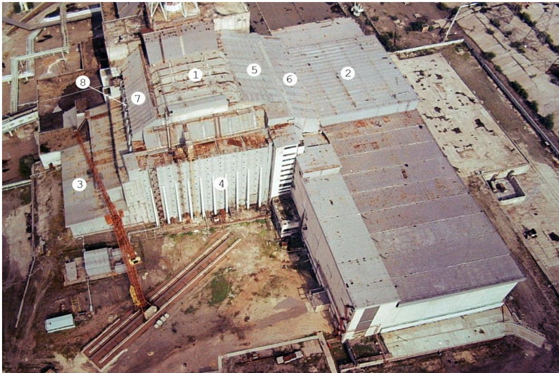
Рис. 1.4. Зовнішні захисні конструкції ОУ: 1 – покриття над центральним залом; 2 – покриття над машинним залом; 3 – каскадна стіна; 4 – західна («велика») контрфорсна стіна; 5 – південні щити; 6 – південні щити-«ключки»; 7 – північні щити-«ключки»; 8 – північна («мала») контрфорсна стіна.
