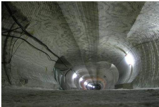
**Рис. 5.71. Камера, отработанная комбайнами (Артемовск, Украина)**
