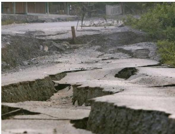
Рис. 1.6. Трещины на поверхности в результате землетрясения
