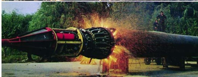
Комплекс “Север” для контактной сварки труб магистральных трубопроводов
