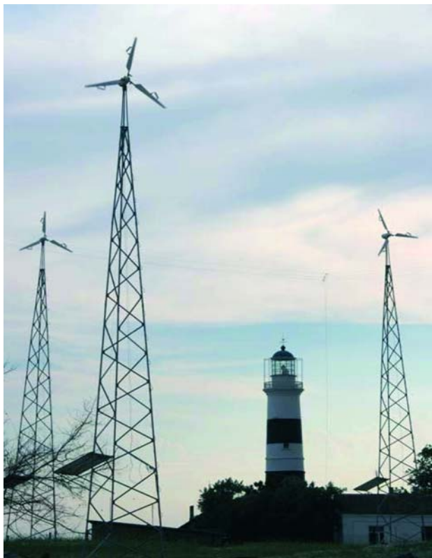
Рис. 8. Автоматизированная ветро-солнечная электростанция на Тендровском маяке
