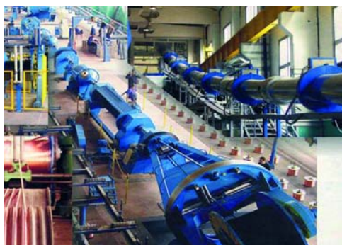
Линия изготовления кабелей с полимерной изоляцией на напряжение до 110 кВт на заводе “Южкабель”
