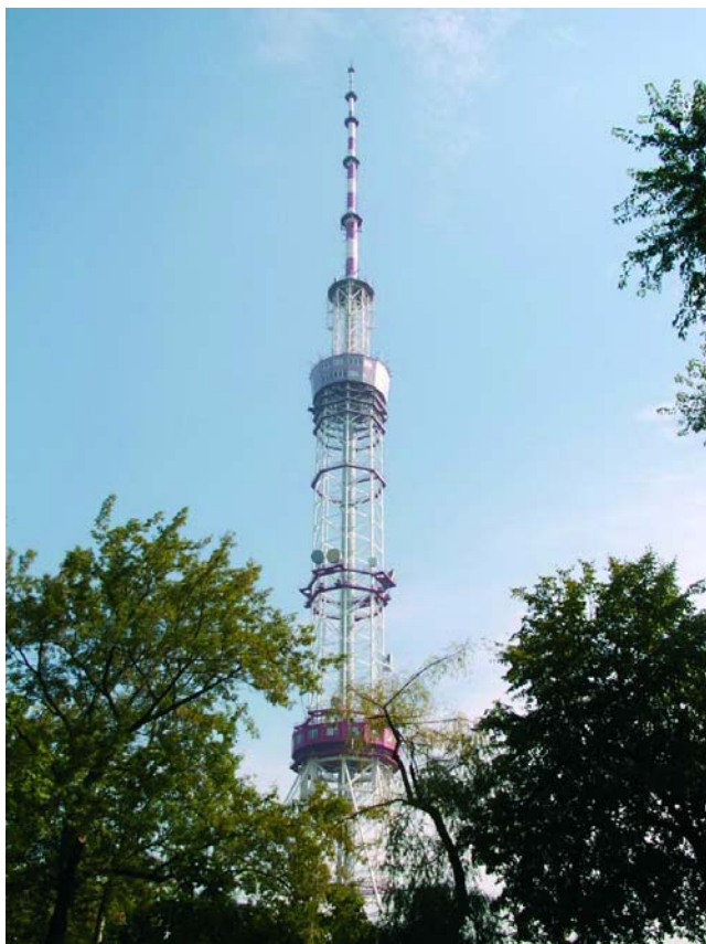
Телевизионная башня, сооруженная по технологии Института электросварки им. Е.О. Патона АН УССР в 1973 г.
