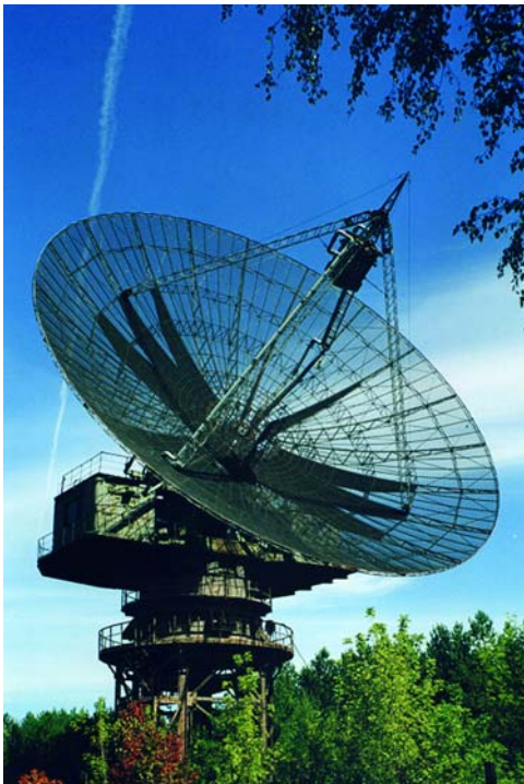
Полноповоротная параболическая антенна диаметром 25 м
