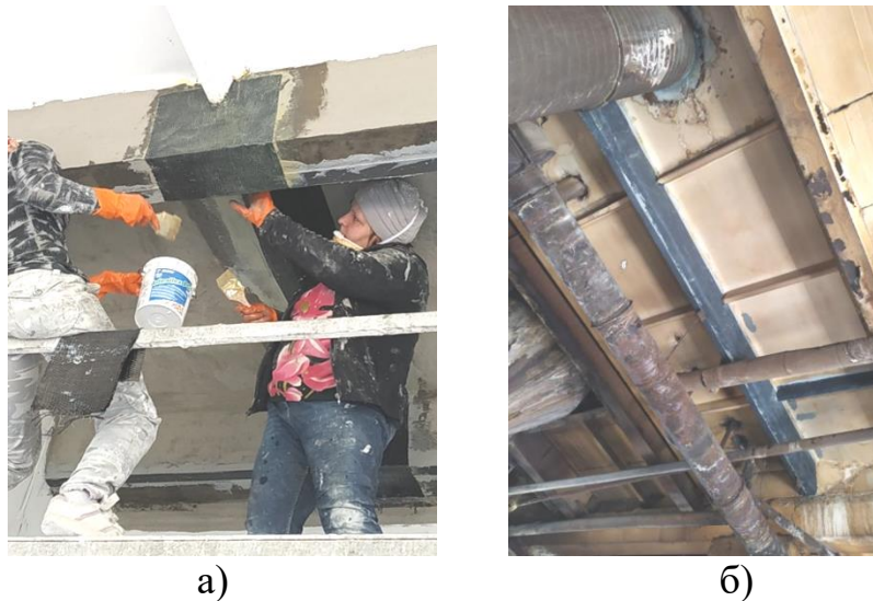
Рис. 13 Процес підсилення ребристих плит покриття (а) та підсилені конструкції (б)
